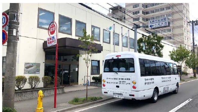
⑫ 札幌市水道局（八軒庁舎）
